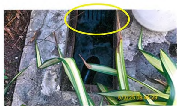
ภาพถ่ายที่ 2.2-65 ตะแกรงดักขยะที่บ่อตรวจสอบสภาพน้ำ
